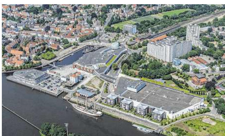
Vorne das Schul-schiff, dahinter das Haven Hööv: ein Teil wurde umgebaut, ein anderer wird abgerissen. Die Arbeiten sollen Monate dauern. FOTO: KÄRSTEN KLAMA
